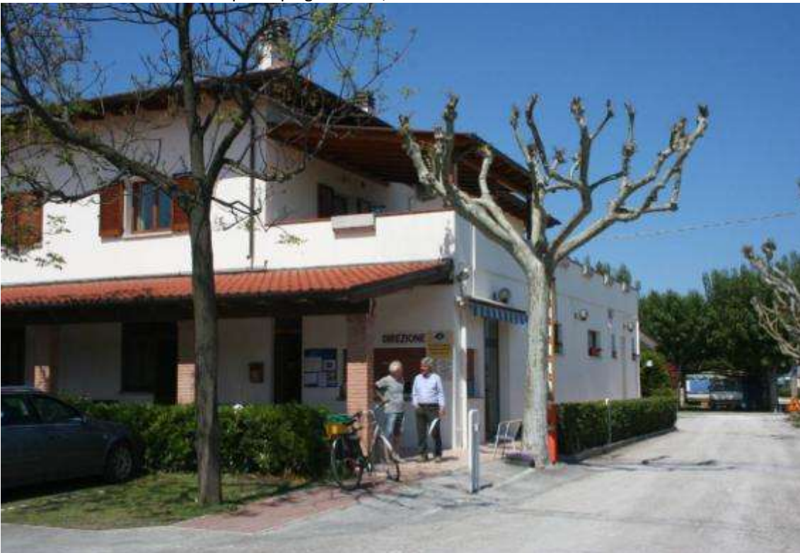
Hoofdgebouw Camping Mare Blu, Fano (Henk is in gesprek met de eigenaar)
