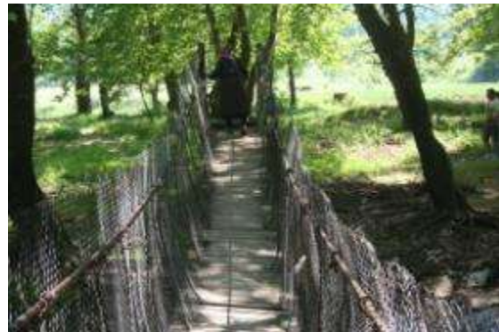
Staalkabelbruggetje over een rivier
